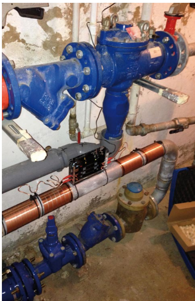
安装在法国ALCOA铝厂的Vulcan S25系统
