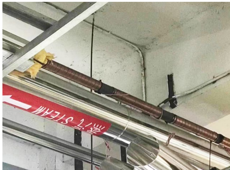
步骤1：安装脉冲带
