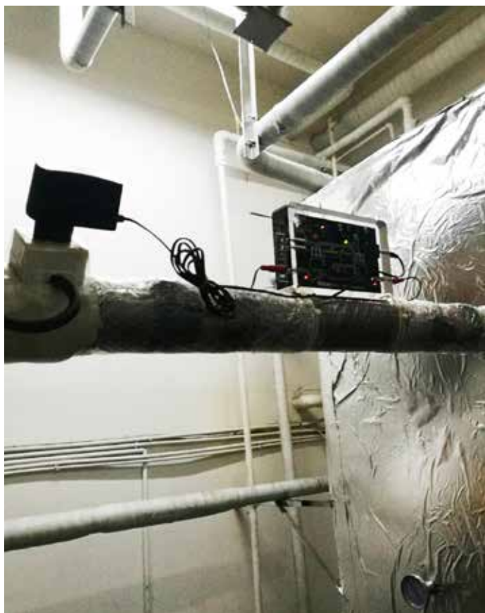
Vulcan S10 安装在换热器前端，解决换热器、水泵、水箱、淋浴喷头、管路等结垢问题。
