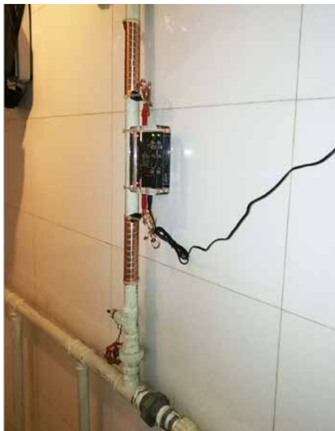
Vulcan 3000 安装在太阳能上水管，解决太阳能真空管结垢问题。
