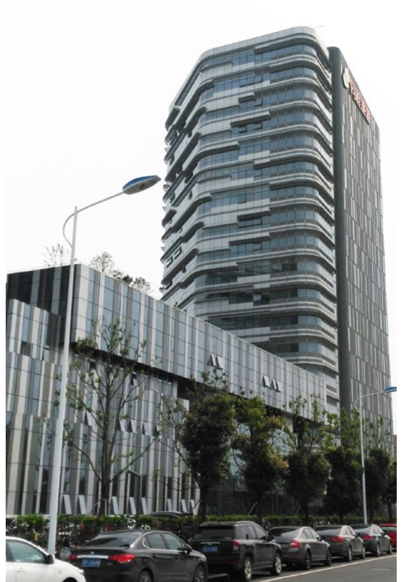
位于苏州的同程网总部大楼
