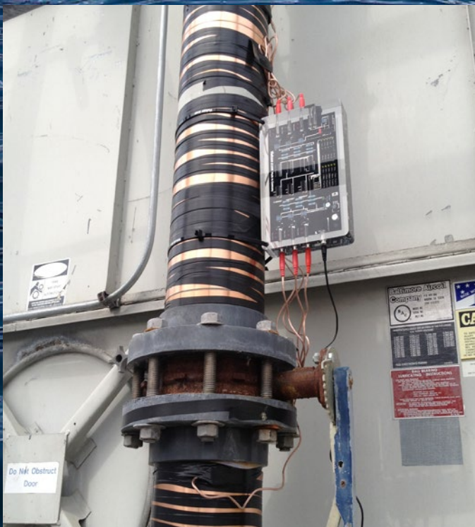
Vulcan S100 安装在冷却塔
