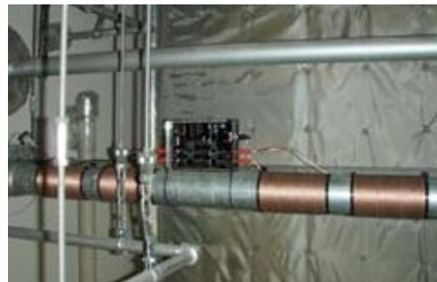
Vulcan S25 安装在循环管道上, 为处理流经冷却塔C的水
