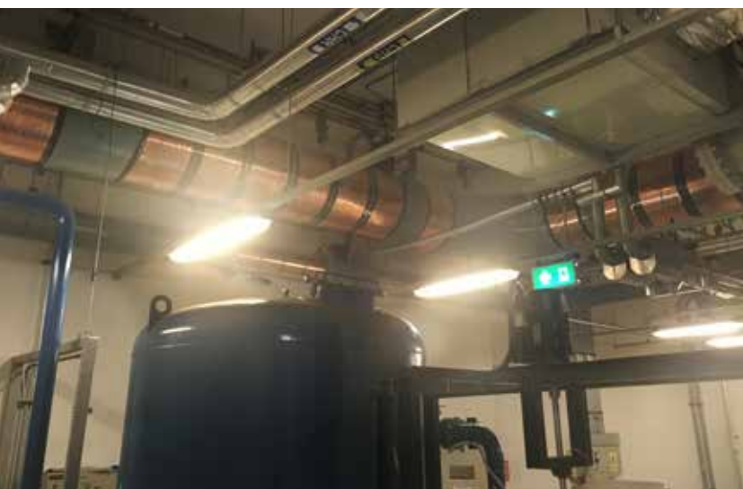
安装在冷凝器的主回水管上的 Vulcan S250 和 X-Pro 1
