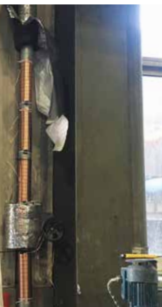
Vulcan S25 安装在铸造车间冷却塔的进水主管道
