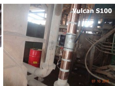
沃肯(Vuclan)安装两个月后的换热器
