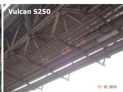
沃肯(Vuclan)安装前的换热器
