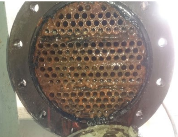
沃肯(Vuclan)安装前的换热器
