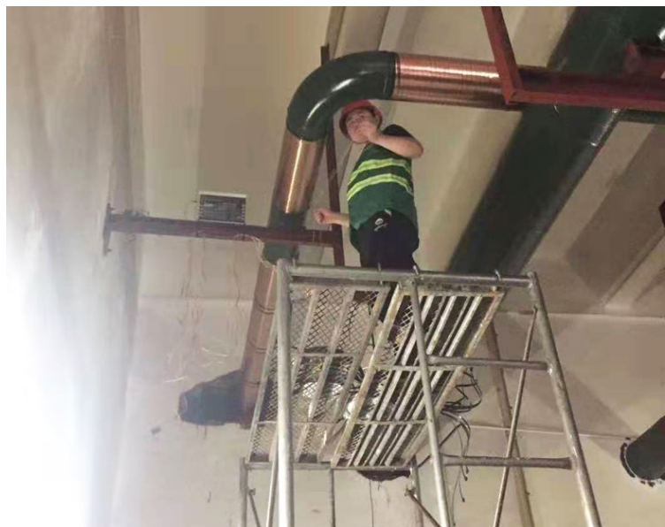
Vulcan S350 安装在纺织设备冷却循环水主管道
