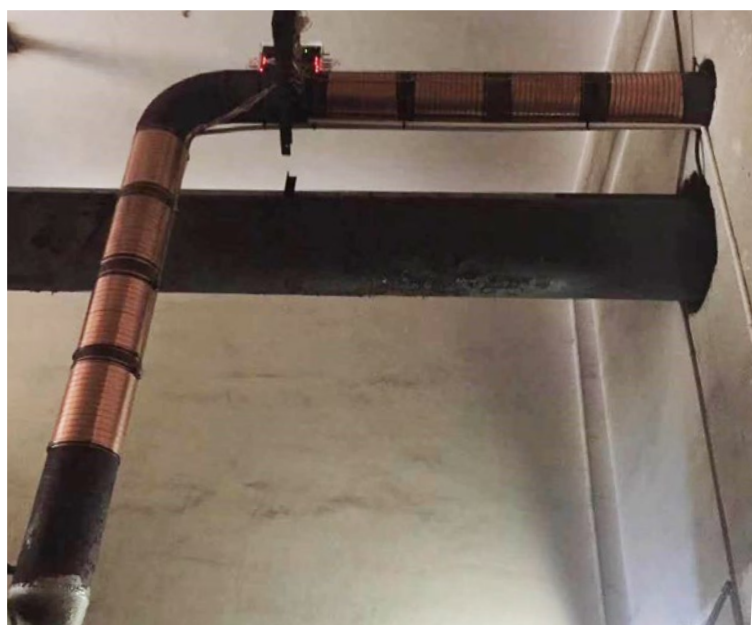
Vulcan 250 安装在纺织设备冷却循环水主管道
