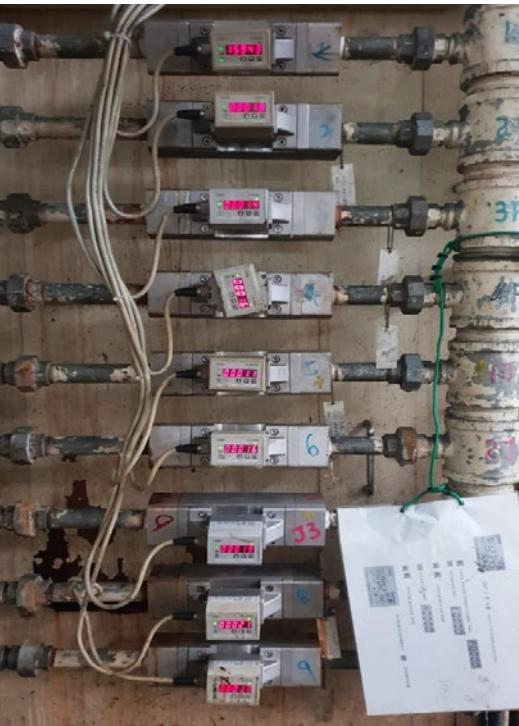
厂房内有9个带水表的二级小管, 水表用来观察并且确保稳定的流速。如果水管堵塞导致流速下降, 则会引起高周波热处理机不能正常运作。因此, 管道在安装沃肯(Vulcan)前, 必须每2-3个月清洁一次。
