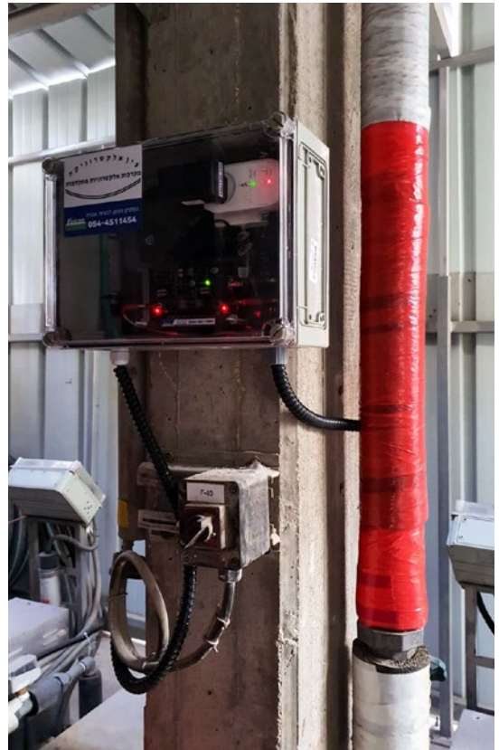
Vulcan 5000 安装在供暖系统的回水管上
