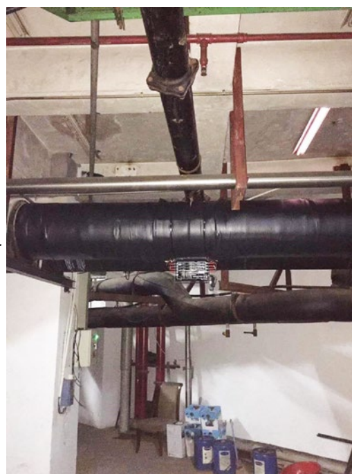
步骤2：管道包裹保温棉，再装上S350主机
