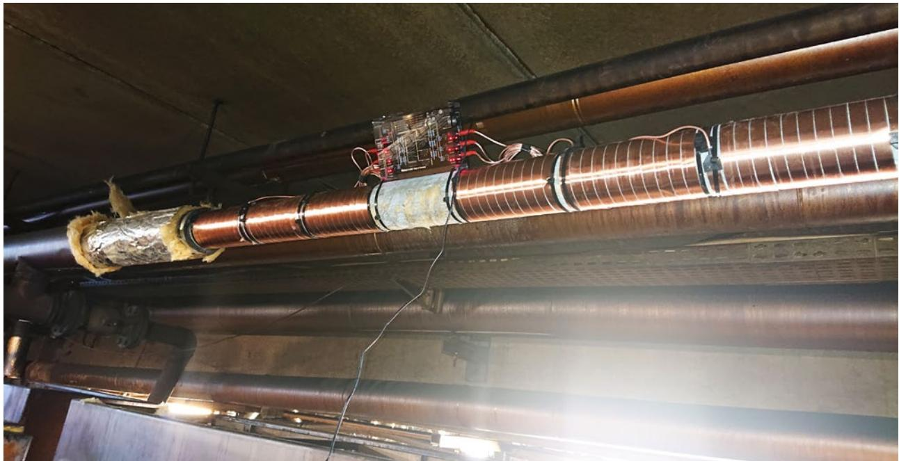
Vulcan S100 安装在主进水管道上, 以解决烹饪室的结垢问题。管道绝缘层被去除以安装脉冲带。
