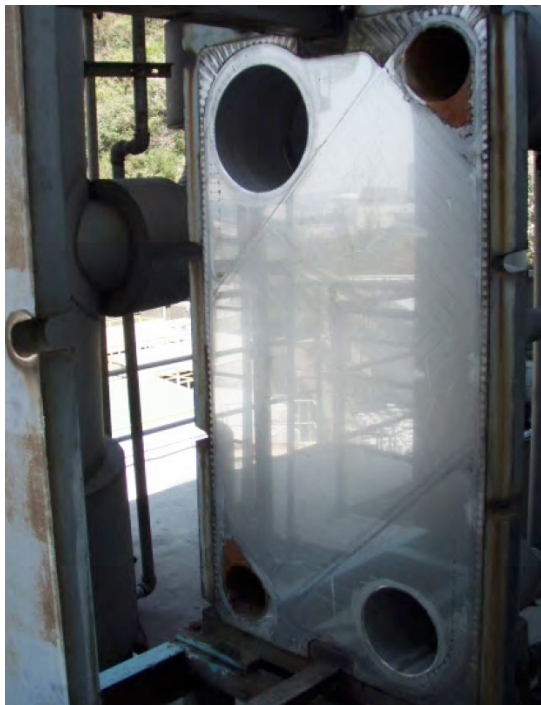
沃肯(Vulcan)安装9个月后：准备打开板式换热器作清洁
