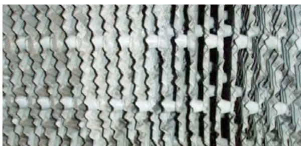
在安装沃肯(Vulcan)之前: 冷却塔的內部
