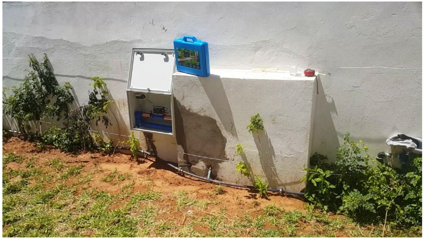
Vulcan 3000安装在新建别墅主水管的室外保护箱，以确保整个管道系统受到沃肯(Vulcan)的保护。
