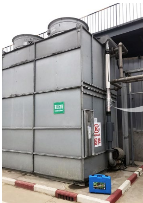
Vulcan S25 安装在冷却塔进水口
