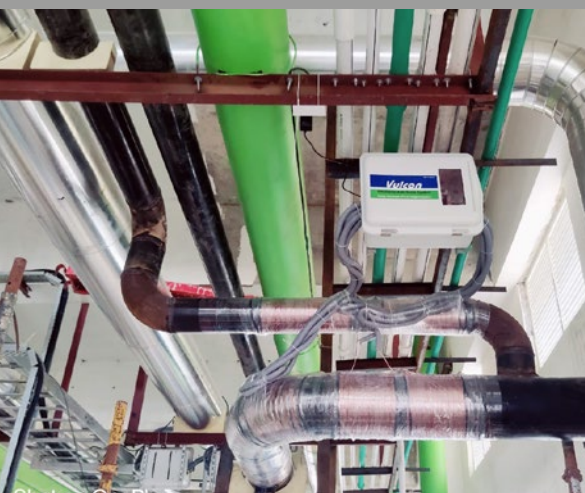
S250 用于挤出机冷冻水管路
