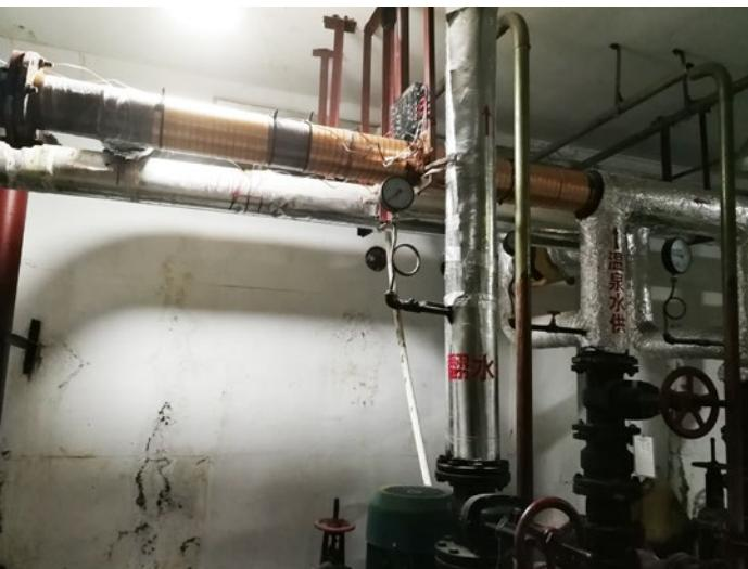
温泉水管路距离输送到别墅房较远，通过水泵加压，在输送管路上安装一台 Vulcan S150。
