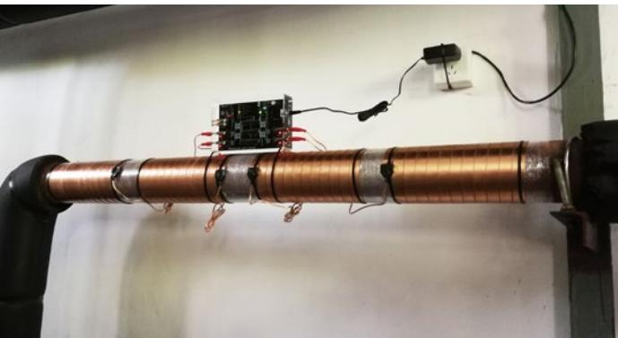
将管道的保温层剥离并清洁，Vulcan S50 安装在取温泉水的机房。
