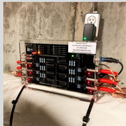
Vulcan S10 安装在27楼的热水循环系统上。安装Vulcan装置之前, 覆盖脉冲带以防止冷凝水。
