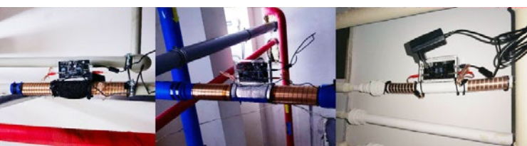
Instalaciones del sistema antical Vulcan.
