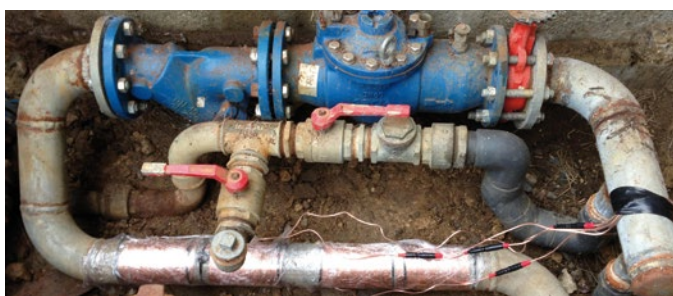
El Vulcan S25 instalado en la fábrica de aluminio Alcoa en Francia
