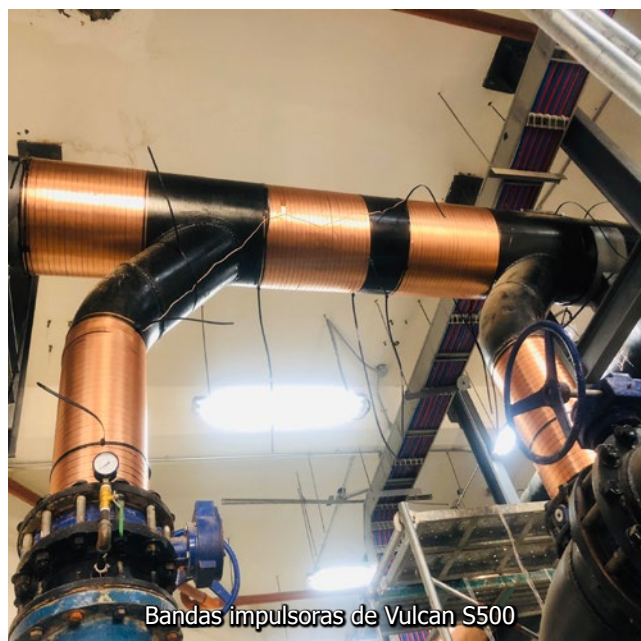
Tratamiento Vulcan S500 en el sistema de aire acondicionado del nuevo hotel — Acacia Hotel Davao
