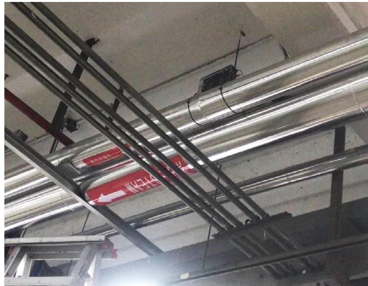
**Paso 2:** Se envolvió la tubería con material aislante y luego se instaló la unidad Vulcan S25.
