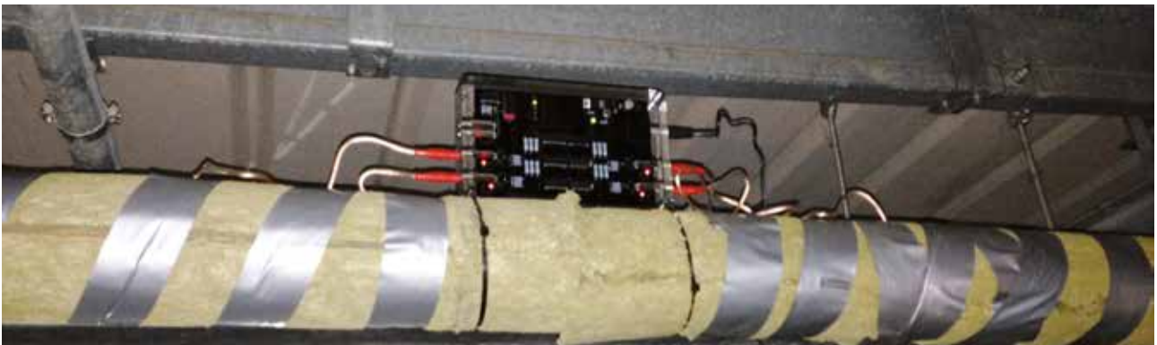
Unidad Vulcan S25 instalada con aislamiento re-envolviendo las tuberías y los cables de impulso
