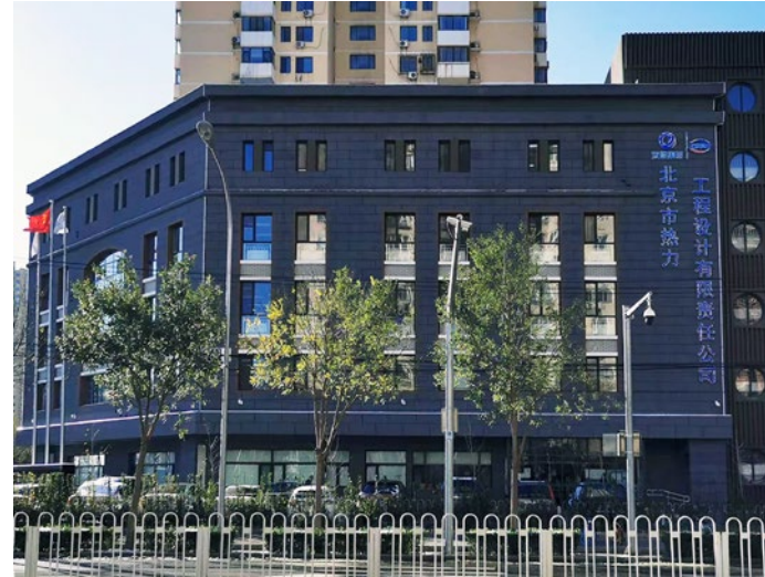
Ingeniería térmica Beijing Ltda.
