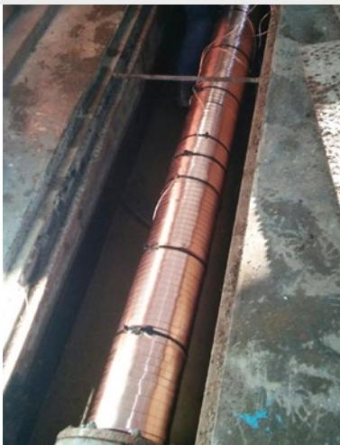
En el pozo se instaló un sistema antical Vulcan S100.
