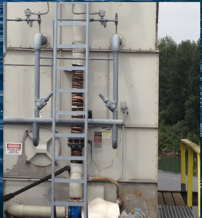
Vulcan S100 instalado en la tubería exterior
