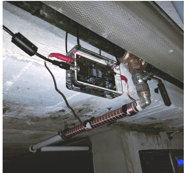
Vulcan 3000 En el tubo del depósito de agua con Ø 25mm
