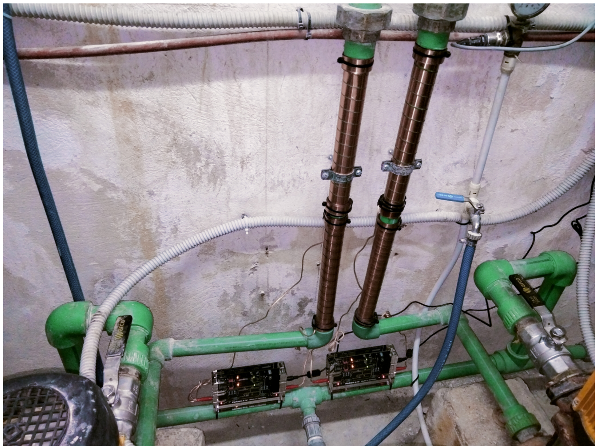
2 x Vulcan S10 En el circuito de agua fría con Ø 41 mm
