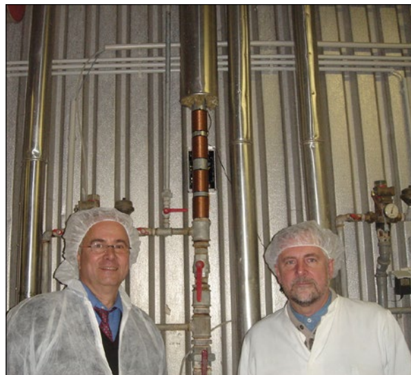
El Sr. Christiani en la instalación de Vulcan
