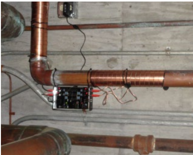
Equipo Vulcan instalado en la tubería de agua principal
