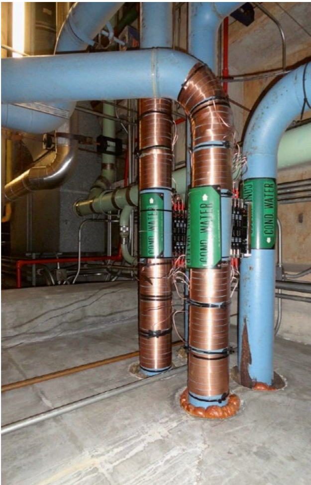
Unidades Vulcan S100 instalados en el doble chiller
