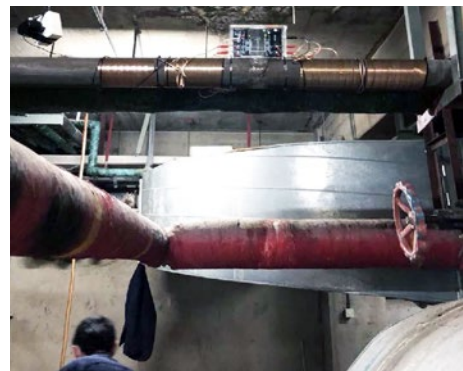
Vulcan S25 instalado en una tubería de cobre DN80.
