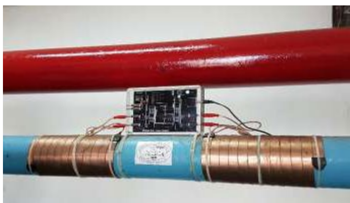
Sistema Antical Vulcan S25 fue instalado
