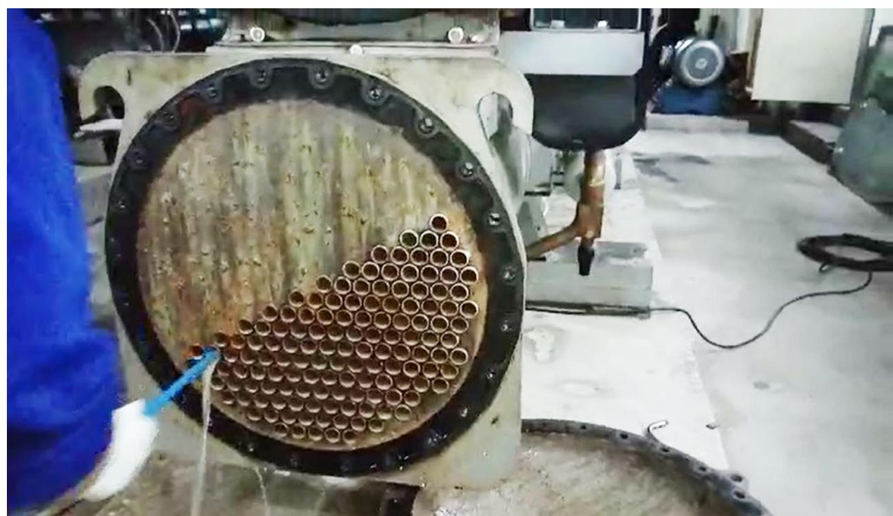
Después de un año de la instalación de Vulcan 5000, los técnicos abrieron el evaporador para limpiarlo: no se encontró absolutamente ningún residuo calcáreo y todas las tuberías estaban limpias.
