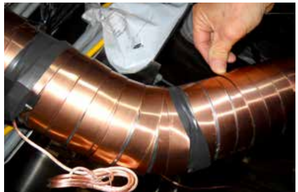
Cables Vulcan de impulso dobles envueltos en la tubería de agua
