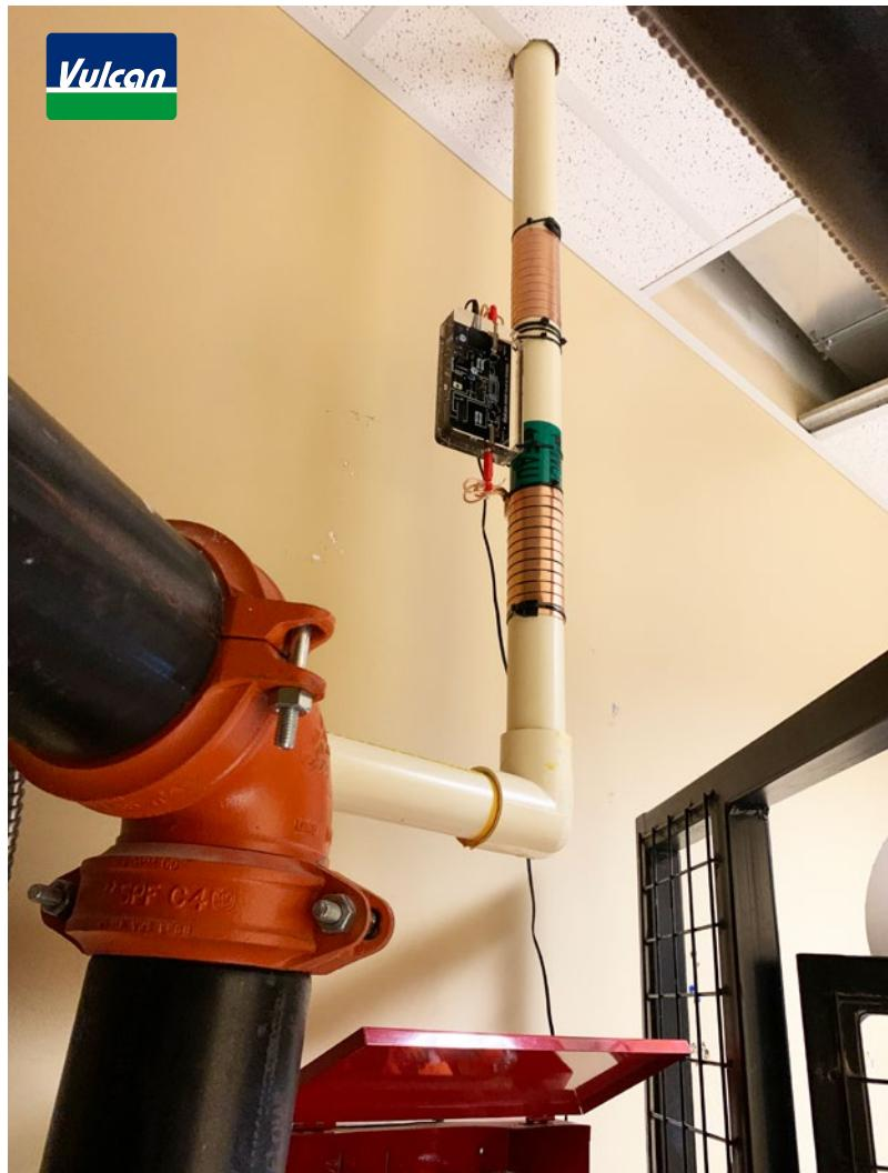
Se instaló un equipo Vulcan 5000 en la entrada de agua principal para tratar el circuito de tuberías.
