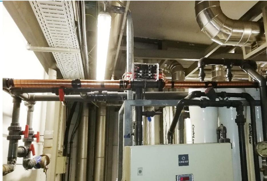
Vulcan S25 se instaló en la tubería de entrada principal para tratar las torres de refrigeración.
