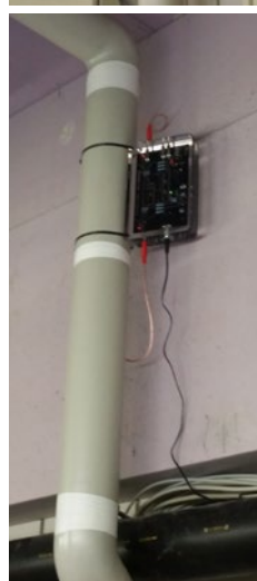
Sistema antical Vulcan en el servicio sanitario de la estación de trenes de Basilea.
