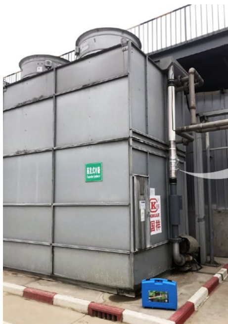
Vulcan S25 instalado en la entrada de agua de la torre de enfriamiento.
