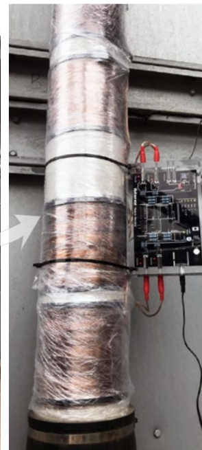
Vulcan S25 instalado en la entrada de agua de la torre de enfriamiento.
