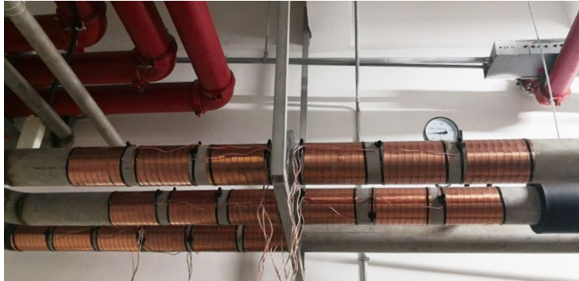
3 equipos Vulcan S100 instalados en la salida del depósito de expansión en el edificio de apartamentos 1
