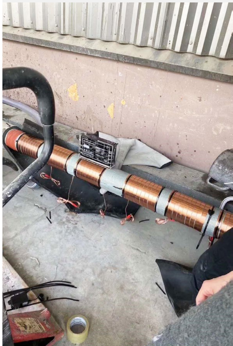
Extracción del aislante de la cañería e instalación de Vulcan S100.
