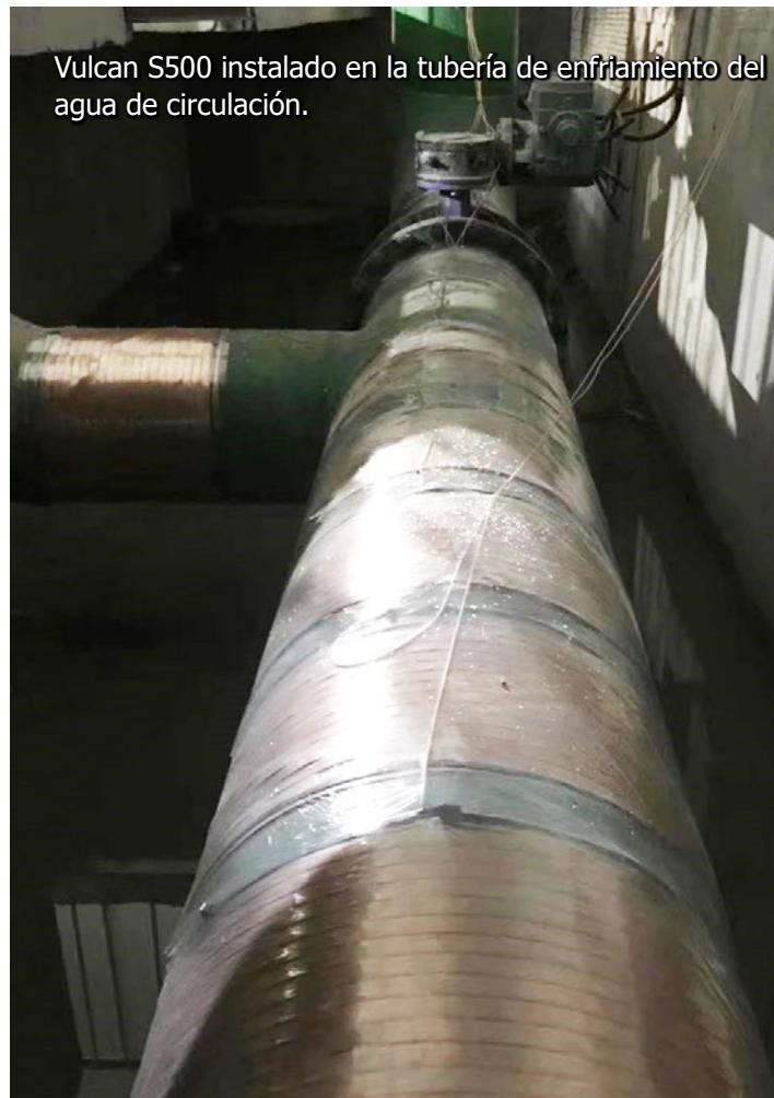
Vulcan S500 instalado en la tubería de enfriamiento del agua de circulación.
