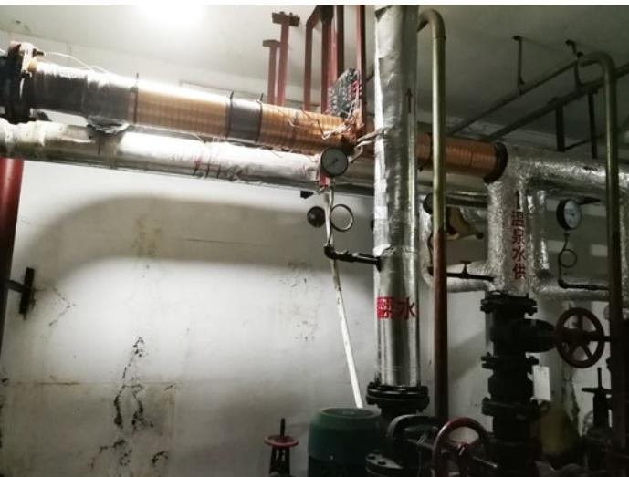
La tubería de agua termal está lejos de la villa, por lo que el agua tiene que ser bombeada. El Vulcan S150 se instaló en la tubería de suministro.
