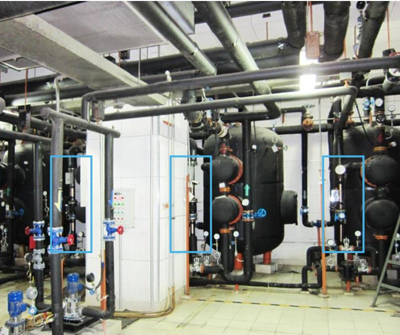
Los tanques negros son intercambiadores de calor. Los intercambiadores de calor han estado en funcionamiento durante mucho tiempo, por lo tanto, la eficiencia se ha reducido debido a la cal. Para ello, se instalaron 3 equipos de Vulcan S10 en la entrada de agua de cada intercambiador de calor.
