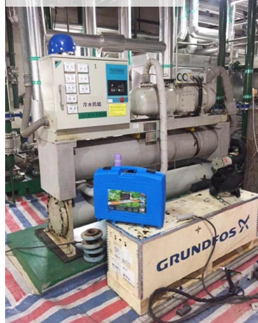
Enfriadores en la central eléctrica
