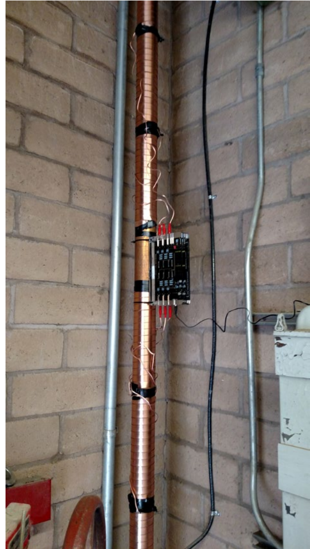
Vulcan S100 instalado en la tubería de agua principal.
