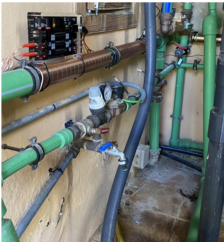
Vulcan S50 en el tubo de agua fría con Ø 63 mm
